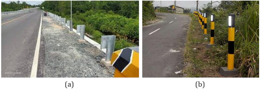
Gambar 9.2. Perangkat pengamanan jalan (a) Guardrail dan (b) Delineator
