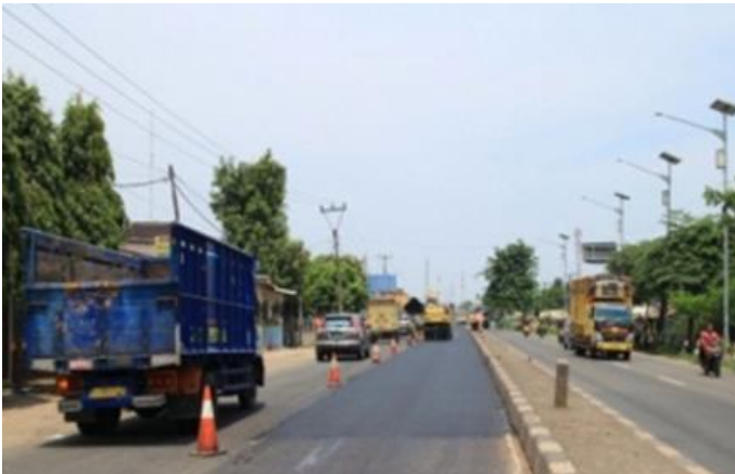
Gambar 9.7. Penggunaan Aspal Daur Ulang Pada Ruas Jalan Pantura Cikampek - Ciasem Daerah Jatisari (Sumber: Bineka, 2021)
