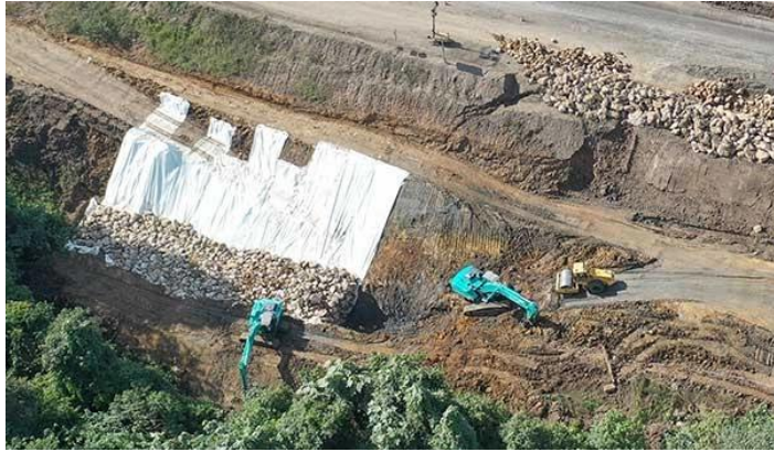
Gambar 4.1. Penggunaan Geotextile dalam stabilitas lereng (Sumber : petra nusa elshada)
