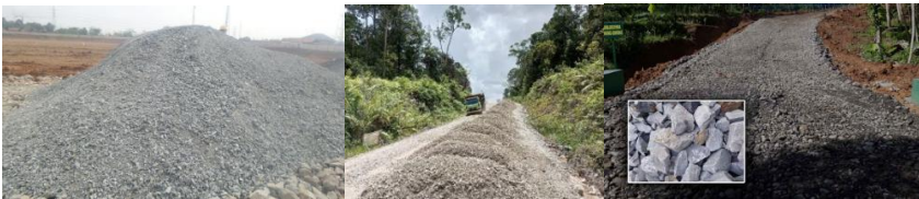
Gambar 7.16. Pelaksanaan Lapis Pondasi Atas ( Base Course ) (Sumber: https://info.kapuashulukab.go.id/2023/09/26/penghamparan-dan-pemadatan-pekerjaan-lapis-pondasi-agregat-klas-a-padaruas-jalan-simp-silat-miau-merah-nanga-silat )
