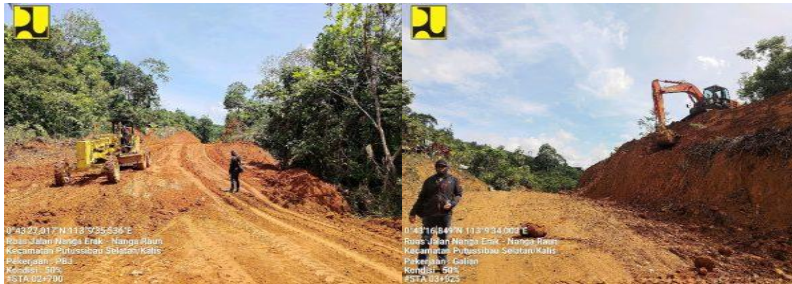
Gambar 7.14. Persiapan lahan dan pekerjaan tanah
