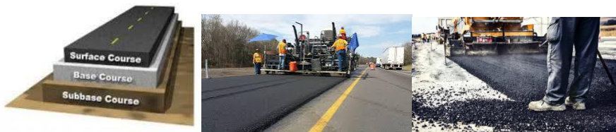
Gambar 7.12. Aplikasi perkerasan lentur pada infrastruktur jalan (Sumber: https://tekniksipil.id/pelaksanaan-perkerasan-lentur-flexible )
