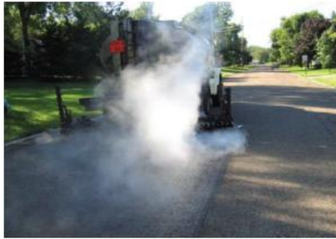
Gambar 11.2. Implementasi fog seal
