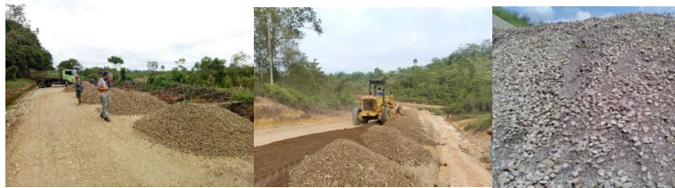
Gambar 7.15. Pelaksanaan Lapisan Pondasi Bawah ( Subbase )
