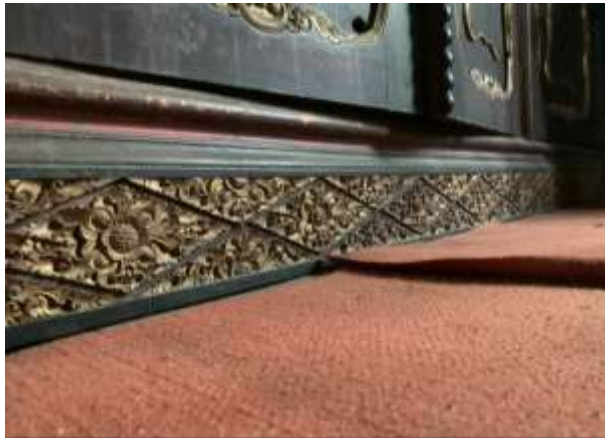
Gambar 2. 29 Ukiran pada Plint Lantai Sumber: Tim Kontributor, 2024
