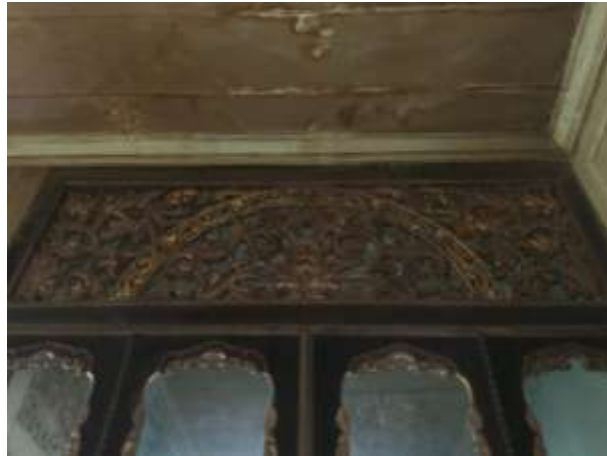
Gambar 2. 15 Roster Kayu Relief pada Interior Rumah Limas Sumber: Tim Kontributor, 2024
