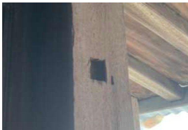
Gambar 2. 37 Bagian Mortise pada Bingkai Detachable Window Sumber: Tim Kontributor, 2024
