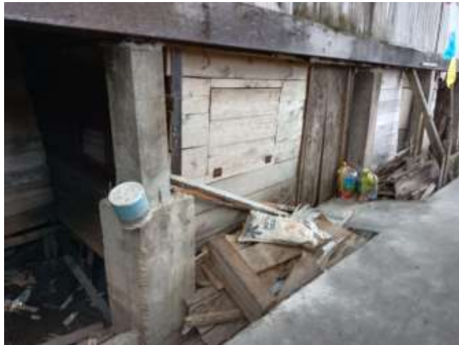
Gambar 2. 7 Penambahan Struktur Beton Sumber: Tim Kontributor, 2024
