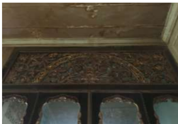
Gambar 2. 26 Roster Kayu Relief pada Interior Rumah Limas Sumber: Tim Kontributor, 2024
