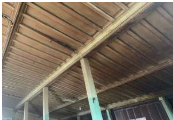
Gambar 2. 25 Susunan Kayu pada Plafon Rumah Limas Sumber: Tim Kontributor, 2024
