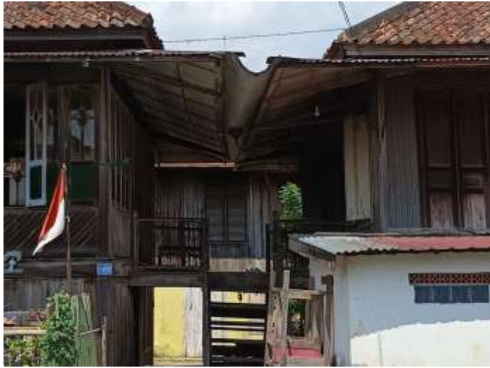
Gambar 2. 86 Tampak Kpridpr Depan Rumah Kembar Sumber: Tim Kontributor, 2024
