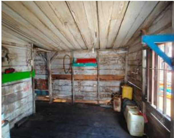
Gambar 2. 64 Interior Gudang Rumah Rakit Sumber: Tim Kontributor, 2024
