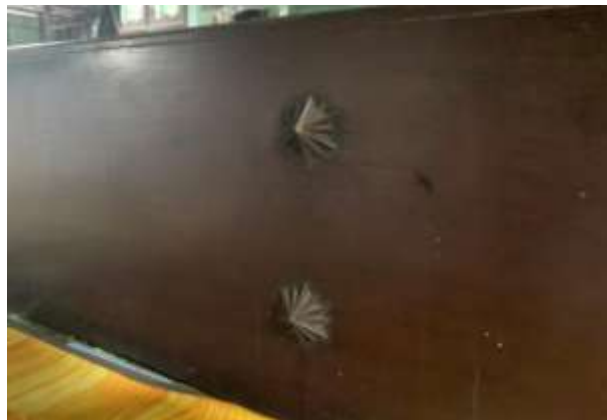
Gambar 2. 36 Detail Kepala Baut pada Balok Lantai Sumber: Tim Kontributor, 2024
