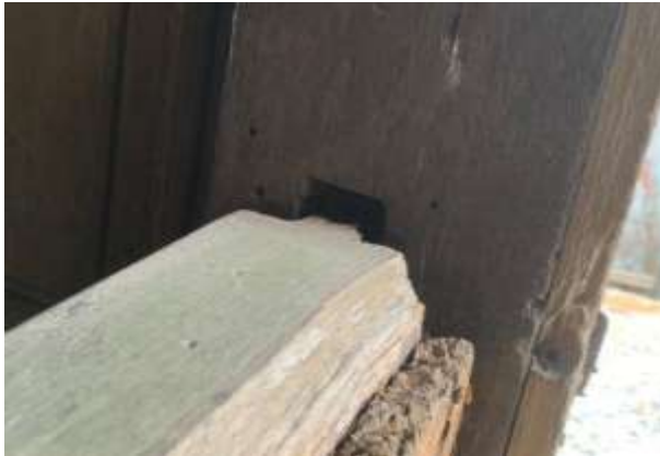
Gambar 2. 38 Detail Sambungan Tenon-Mortise pada Rumah Limas Sumber: Tim Kontributor, 2024
