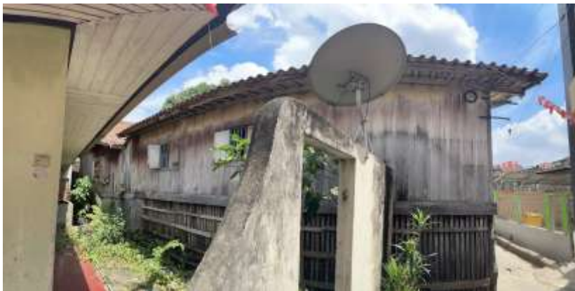
Gambar 2. 101 Tampak Belakang Rumah Baghi Sumber: Tim Kontributor, 2024
