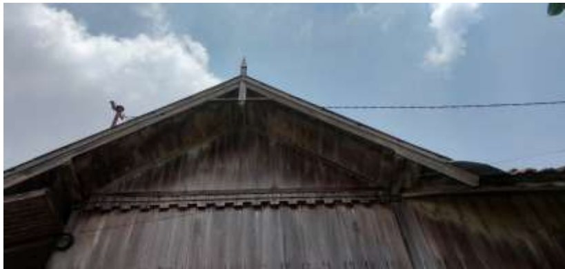
Gambar 2. 52 Detail Atap di Rumah Panggung Sumber: Tim Kontributor, 2024
