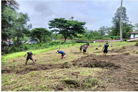
Gambar 2. 1Pembersihan Lahan dengan Metode Manual Clearing
