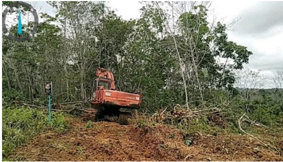
Gambar 2. 2 Pembersihan Lahan dengan Metode Mekanis
